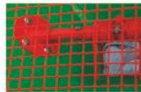
Podgamiak w gardzieli wypowej zbiornika
